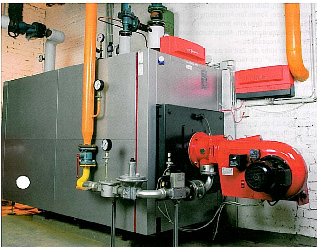
Die Entkalkung erfolgt mit einem umweltfreundlichen Opferanodensystem
