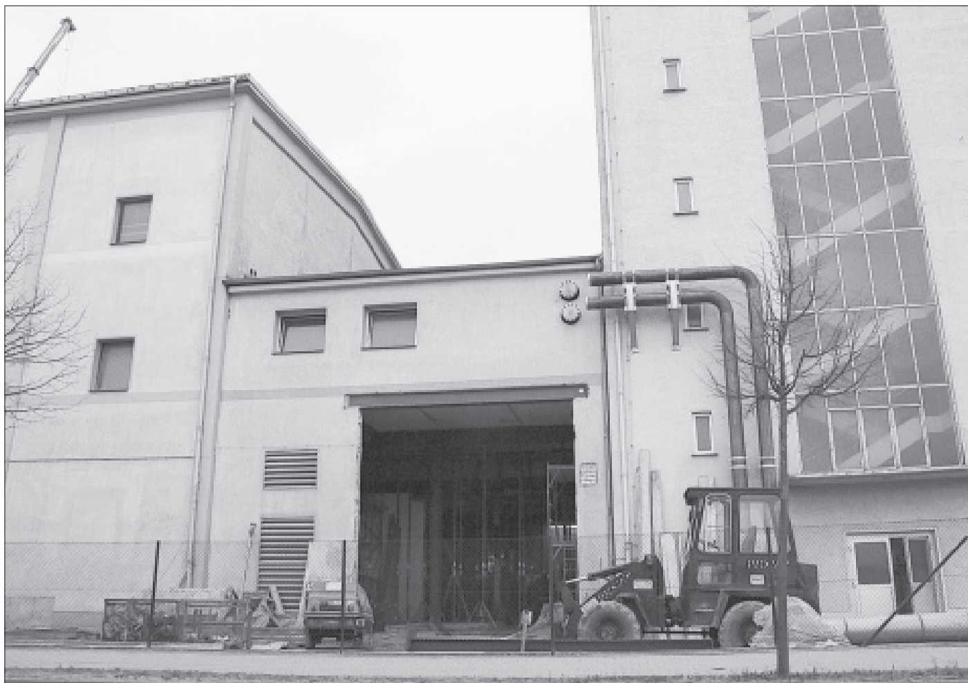
Seit Monaten wird an der Arneburger Straße intensiv gearbeitet. Während auf der einen Seite das Holzpelletwerk gen Himmel wächst, findet auf der gegenüberliegenden Seite der Aufbau des Biomassekraftwerkes im Schutz der Mauern des früheren Kraftwerkes statt. Foto: Anke Hoffmeister
